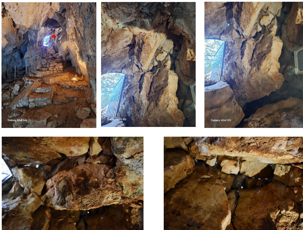
Figura 4-10 evidenza di blocchi scapoli
