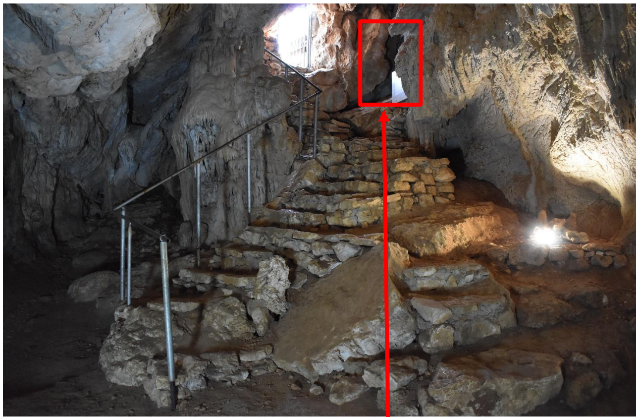
Figura 10_ La scalinata d'accesso, realizzato in blocchi lapidei incoerenti.
