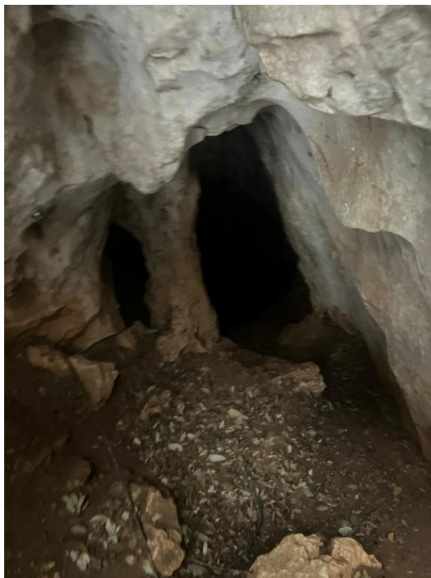
Foto 04 – Foto Ante intervento – Imbocco “Su Benticheddu”
